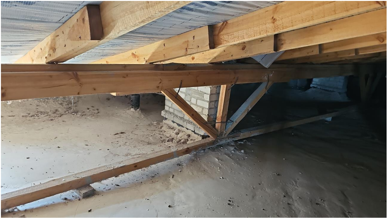
Рисунок 10 – Характерний стан дерев'яних конструкцій даху
