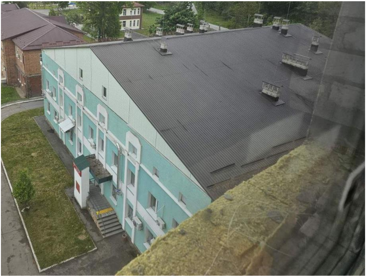
Рисунок 6 – Загальний вигляд покрівлі будівлі
